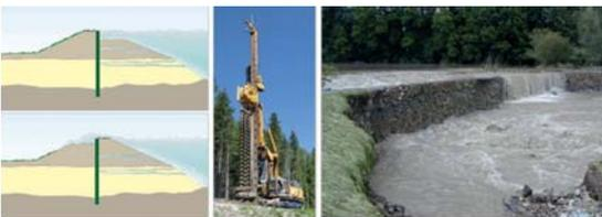
Ilust. 31: Técnica de triple tornillo con Mixed-in-Place. El MIP-muro, al ser superado evita que el dique se colapse durante la inundación
